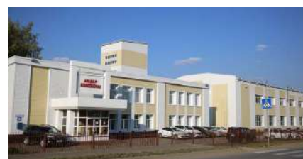
ЗАВОД ЛИДЕР-КОМПАУНД г. Саранск
