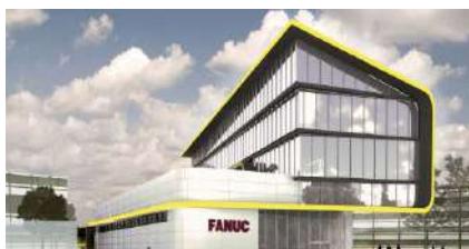
ЦЕНТР FANUC В СКОЛКОВО Московская область
