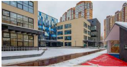
НОВЫЙ КОРПУС ШКОЛЫ № 158 г. Москва
