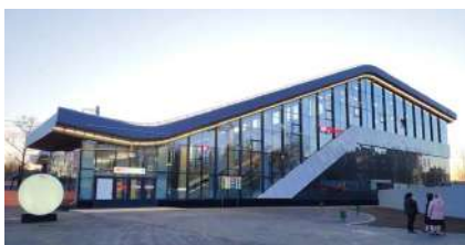
СТАНЦИЯ МЦД ОПАЛИХА Московская область
