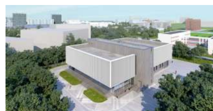
ФОНДОХРАНИЛИЩЕ г. Кемерово
